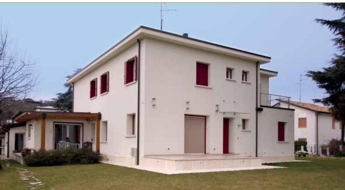
La casa dopo l'intervento di ristrutturazione
